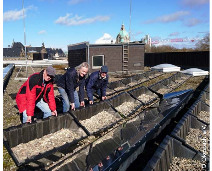
Rückbau der ersten Solaranlage auf dem Dach der Leibniz-Bibliothek als Gemeinschaftsaktion
