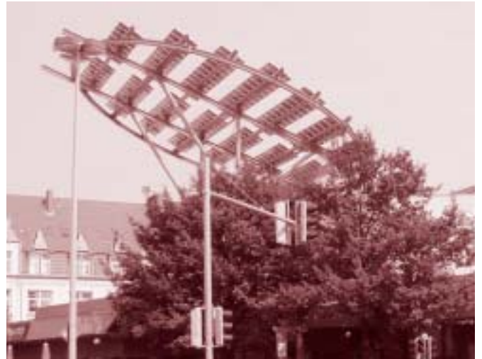
Vorzeigeprojekt „SolarPavillon Hannover“
